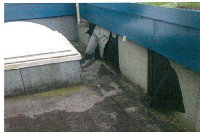
屋上防水シート
