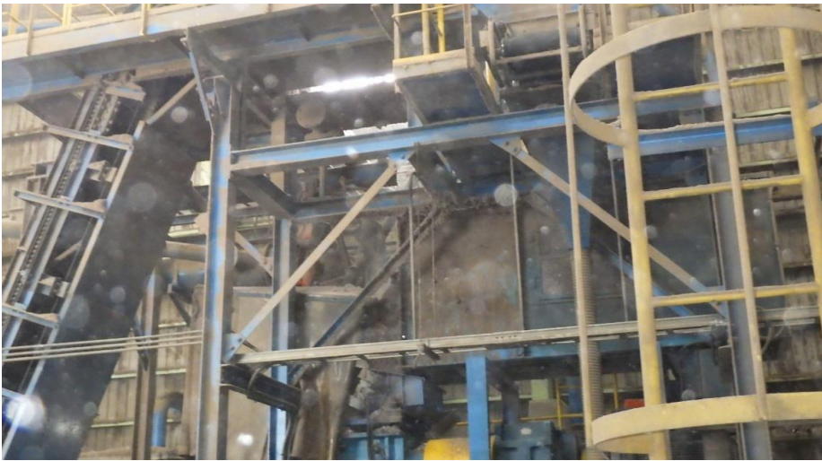
製造ライン(破碎機)
