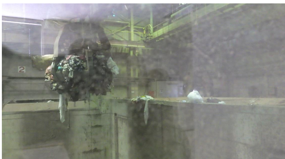
クレーン操作室
